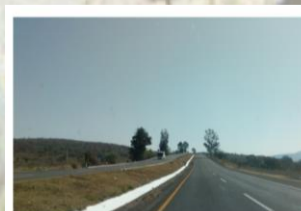
Figura 8 Tramo Morelia - Pátzcuaro km 25+600
