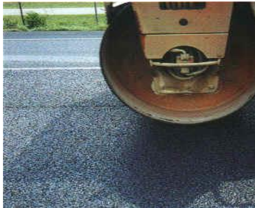
Figura 1.- Pavimento asfáltico tipo SMA. (Fuente: e-asfalto).
