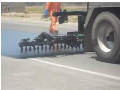
Figura 1. Aplicación de riego con emulsión asfáltica.
