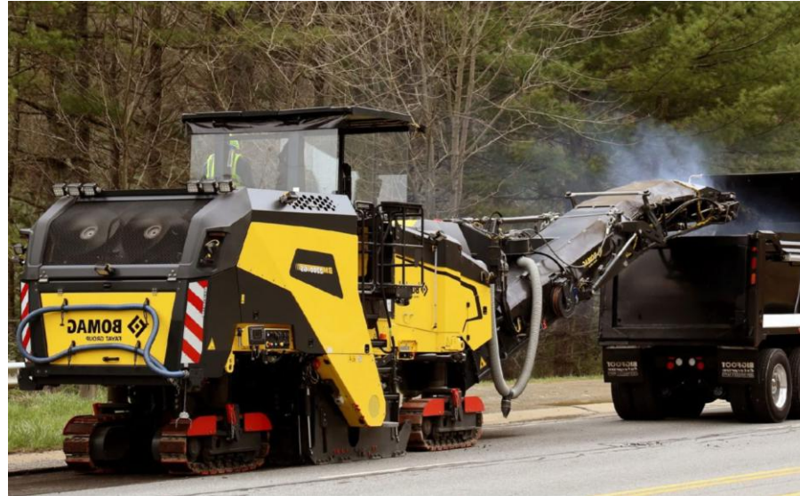
Fresado de la carpeta asfáltica
