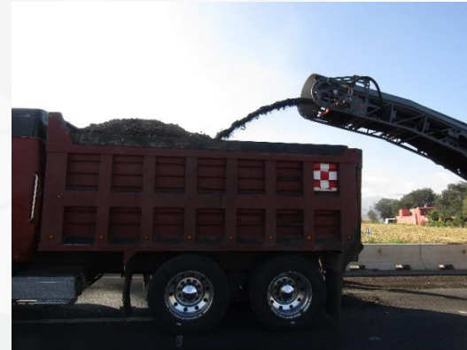
Fresado de 30 y 50 mm
