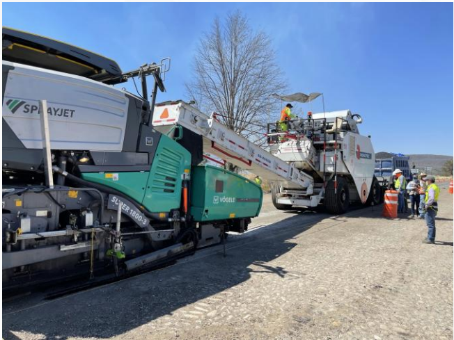
Tren de Tendido
