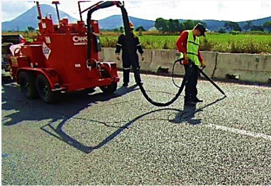
Selladores de Grietas
