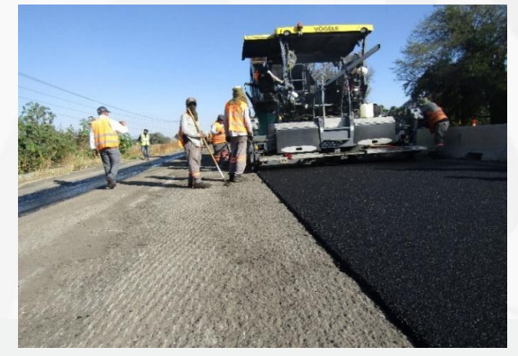
Microcarpeta de 30 mm y Carpeta Asfáltica de 50 mm
