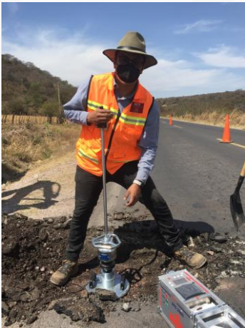
Verificación de módulos por capa
