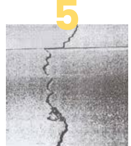
AGRIETAMIENTO TRANSVERSAL
