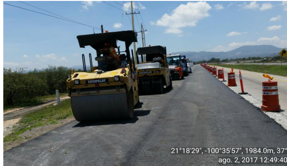
Fig. Colocación de carpeta asfáltica de alto desempeño.
