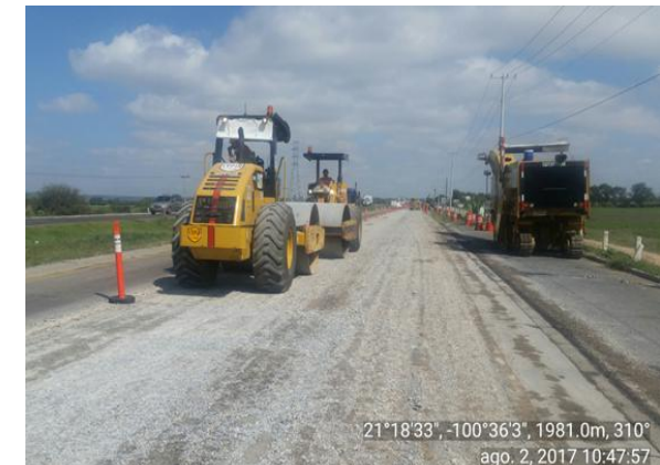
Fig. Proceso de compactación post rubblizing.
