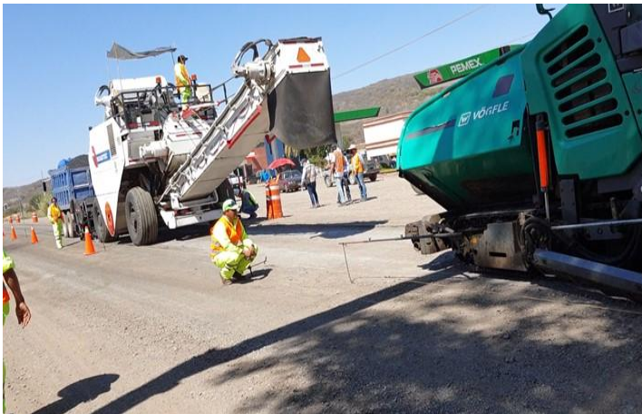
Mezcla asfáltica en frío, con emulsión.
